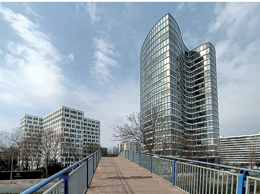
Fußgängerbrücke über den Kennedydamm
